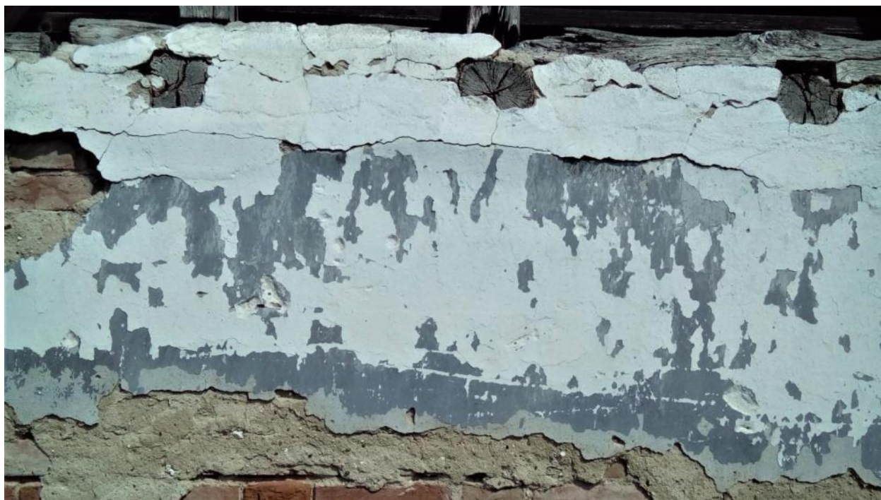
Слика 148, зид старе куће, Кладово, Србија
