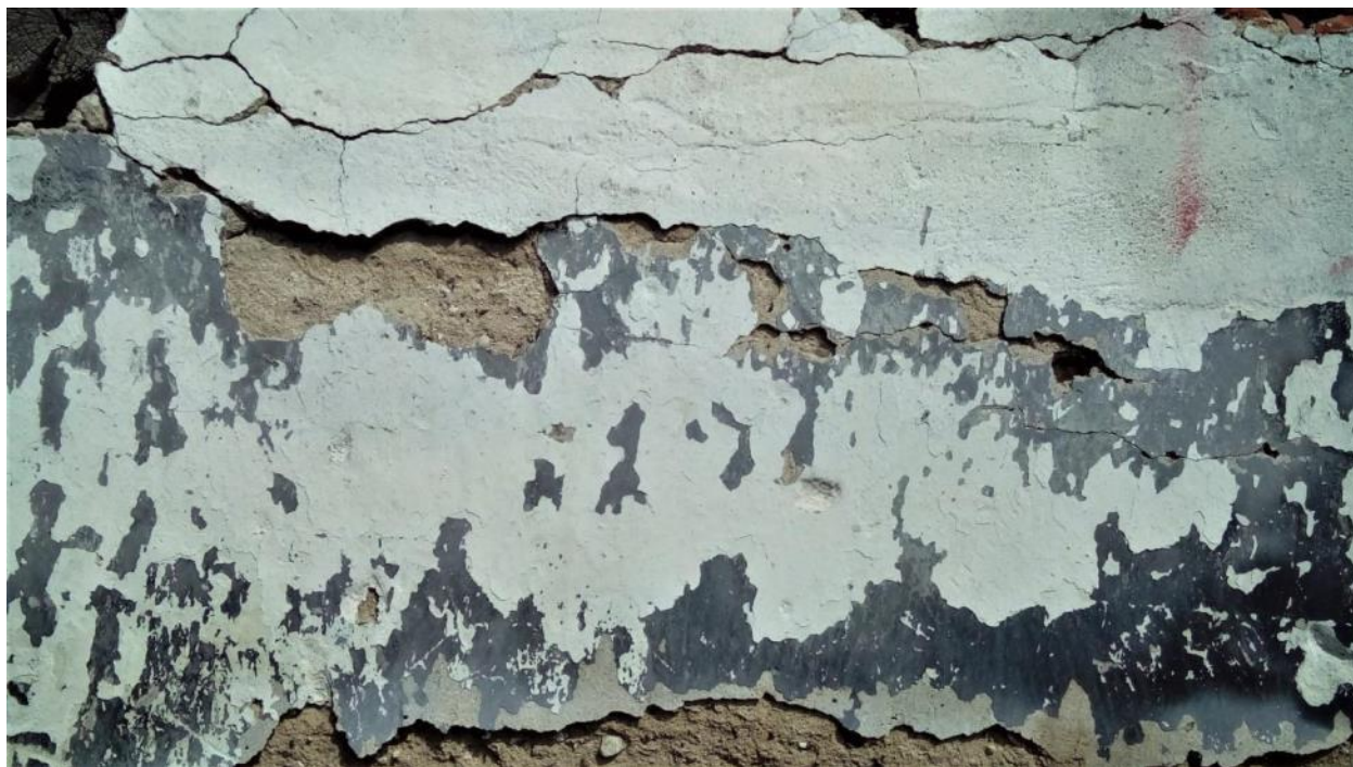
Слика 147, зид старе куће, Кладово, Србија
